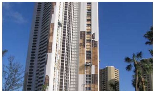
飓风“珍妮”的强风对建筑物外围结构的损坏 (来源: AIR)
